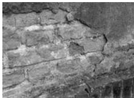
Bild 10. Putzablösungen
