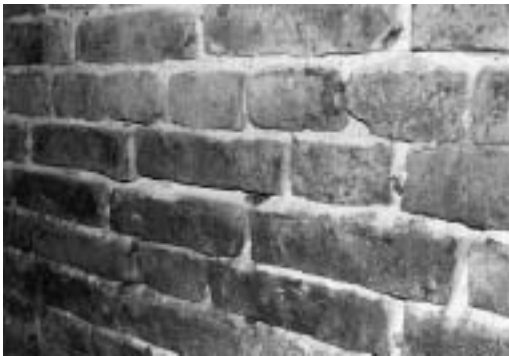
Bild 11. Mörtelfugenaussandungen
