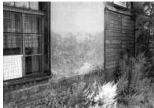
Bild 14. Feuchtesäume
