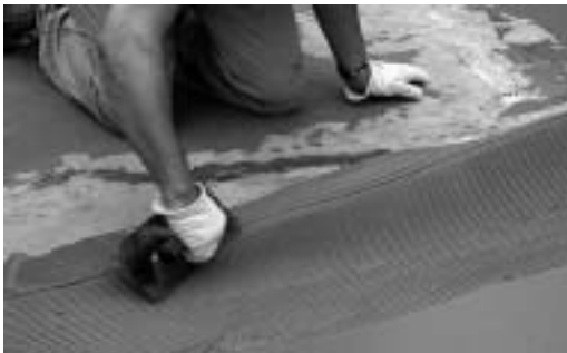
Bild 10. Verteilen der flexiblen Dichtungsschlämme mit dem Zahnpachtel (Foto: PCI-Augsburg)
