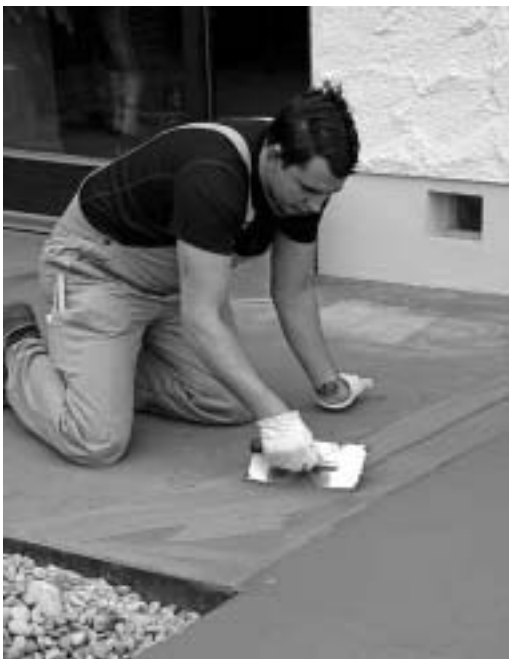
Bild 11. Glätten der Abdichtung (Foto: PCI-Augsburg)
