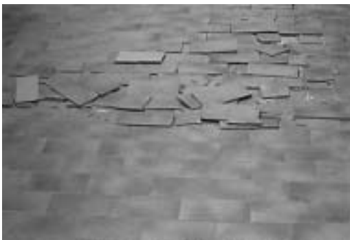
Bild 4. Schadensbild aufgrund eines zu frühen Aufbringens des Keramikbelages auf den Untergrund – vgl. hierzu Bild 3 (Foto: Firma Sopro)
