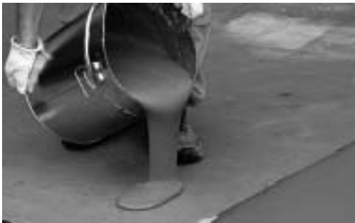
Bild 9. Aufbringen der flexiblen Dichtungsschlämme aus Kunststoff-Zementmörtel (Foto: PCI-Augsburg)
